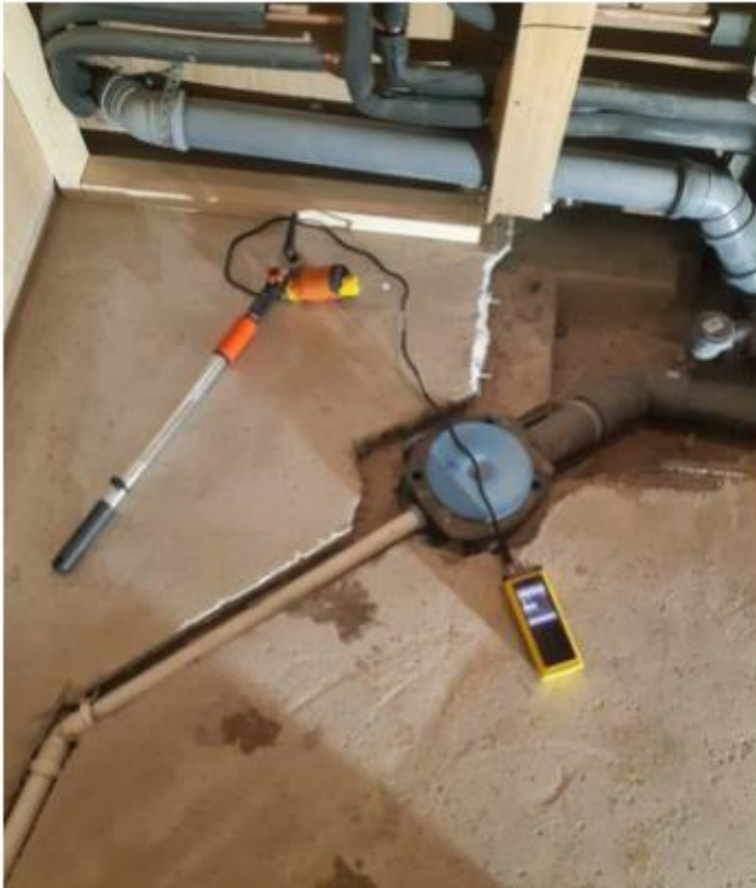
Kuva 5. Valvontamuistiosta. Seinäkaivo on siirretty onnistuneesti lattiakaivoksi. Kylpyhuone-elementin pohjalaatta on roilottu ja lattia-kaivon viemäri on sijoitettu kantavan laatan elementin kolo-osaan.
