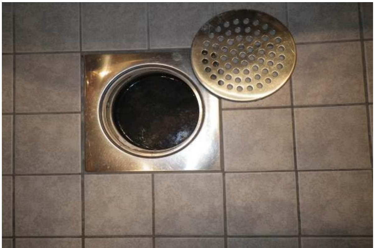
D44 kylpyhuoneen kuivakaivo
