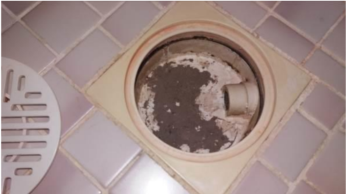
C28 kylpyhuoneen suihkukorokkeen kuivakaivo
