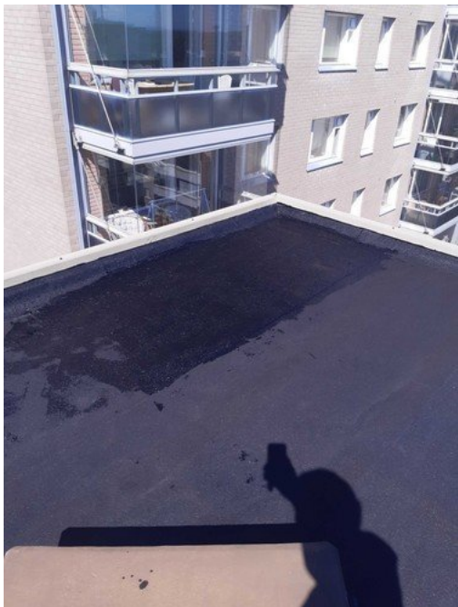
Kuva 7 B-C primerointi kesken.
