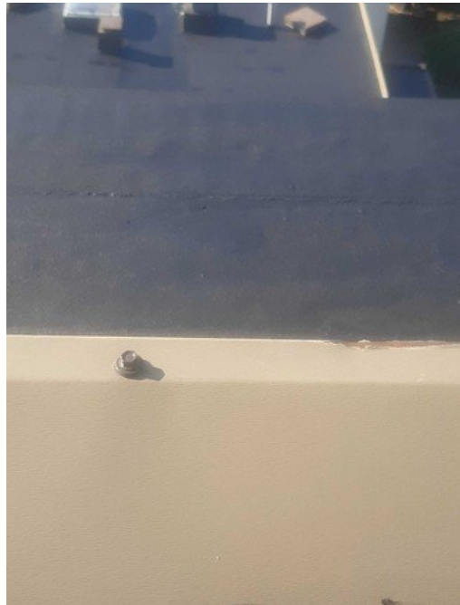
Kuva 26 Uusittu reunapellin ruuvi.
