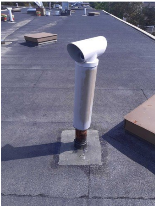
Kuva 5 Tiivis läpivienti.
