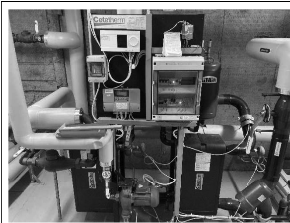
Kuva 1. Lämmityksen alajakokeskus.
