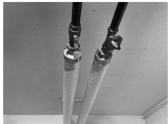
Kuva 4. Lämpöjohtojen venttiileitä
